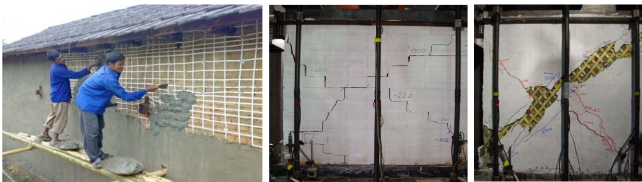
Slika 2.51 Pojačanje polipropilenskim mrežama [4]
