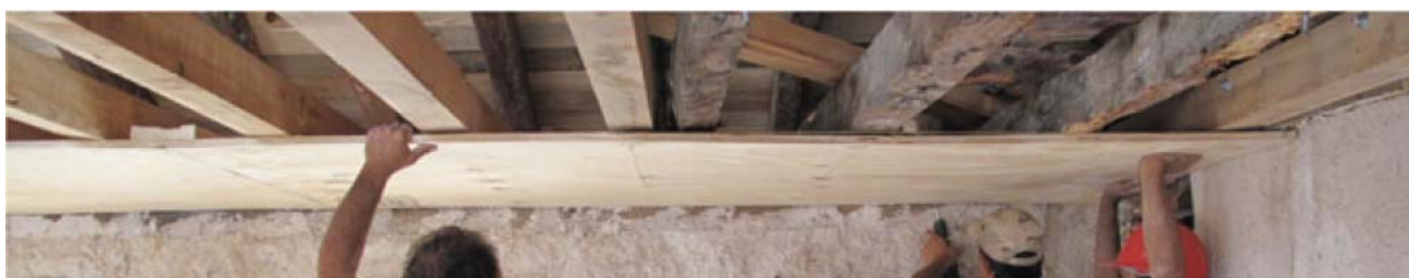
Slika 2.8 Postavljanje šperploče ispod grednih nosača
