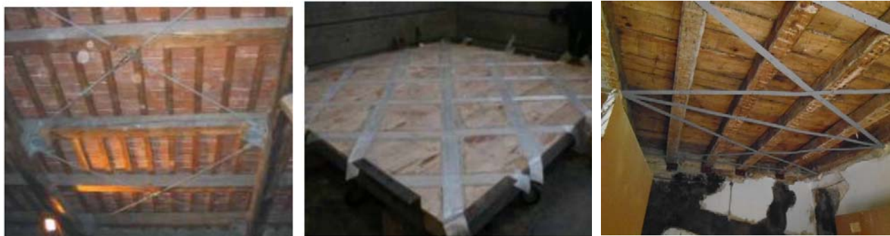
Slika 2.18 Horizontalna rešetka od metalnih traka ili FRP lamela
