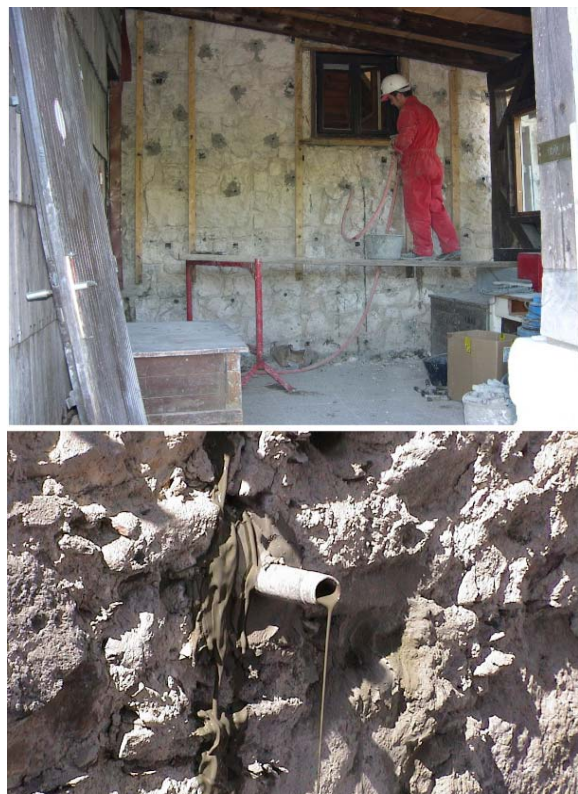
Slika 2.28 Postupak injektiranja zidanih zidova (lijevo) i fotografija injektiranja (desno)
