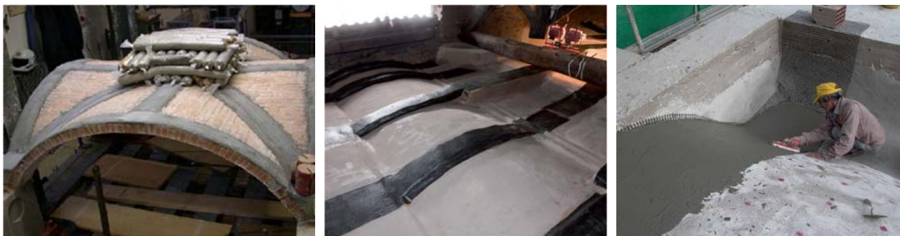
Slika 2.81 Prikaz izvedbe pojačanja svodova
