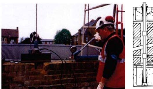
Slika 2.85 Prednapinjanje FRP užadima [8]
