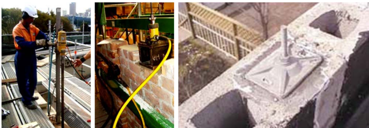
Slika 2.62 Prikaz izvedbe prednapinjanja [4]
