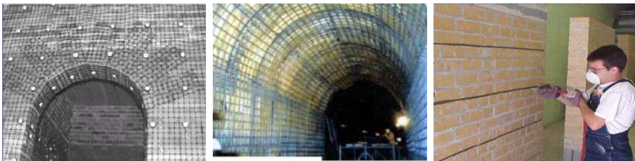
Slika 2.82 Primjeri pojačanja mrežama i šipkama
