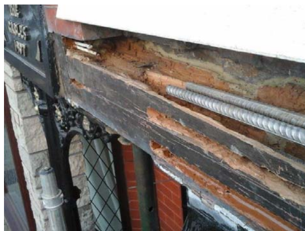
Slika 2.9 Sanacija drvenih greda čeličnih šipkama i epoksidnim mortom
