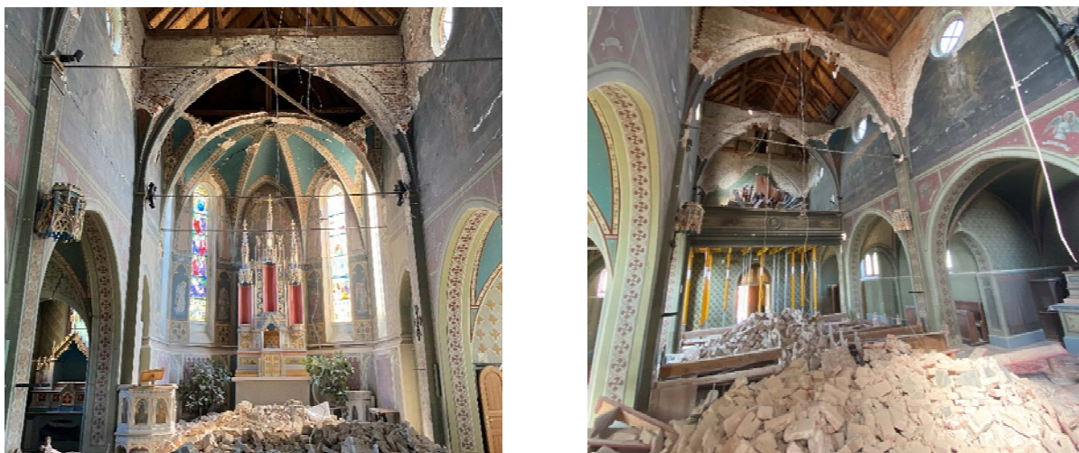
Slika 1.1 Fotografije oštećene župne crkve u Granešini nastradale u potresu 22.03.2020.
