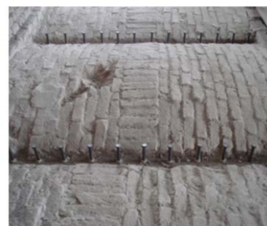
Slika 2.14 Različite varijante sprezanja i izgled stropa
