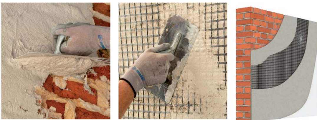
Slika 2.74 Pojačanje FRCM sustavom
