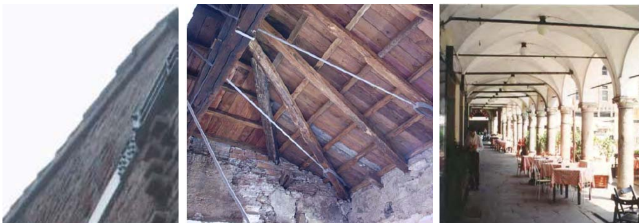
Slika 2.59 Izgled izvedenih pojačanja [4]
