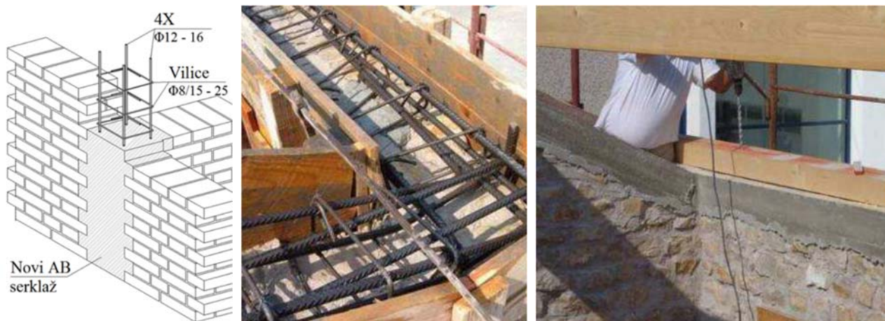
Slika 2.63 Vertikalni serklaž; horizontalni serklaž [4]
