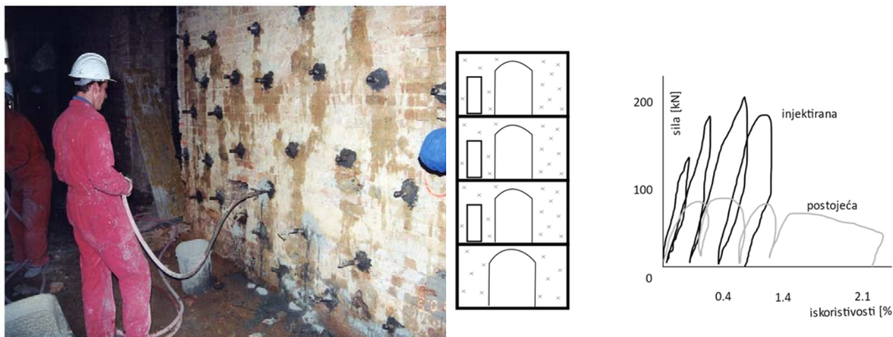
Slika 2.34 Fotografija izvedbe injektiranja zidova i prikaz učinka injektiranja na nosivost
