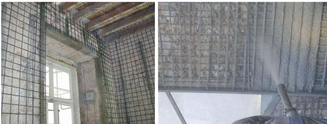
Slika 2.46 Pojačanje armiranim slojem betona [4]
