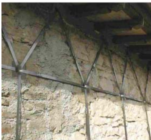
Slika 2.44 Ojačanje trodimenziionalnim CAM sustavom
