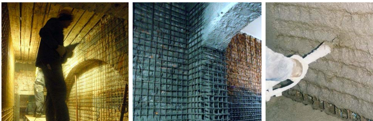
Slika 2.50 Fotografije izvedbe armiranobetonske žbuke (izvor: www.arhitekti.hr )
