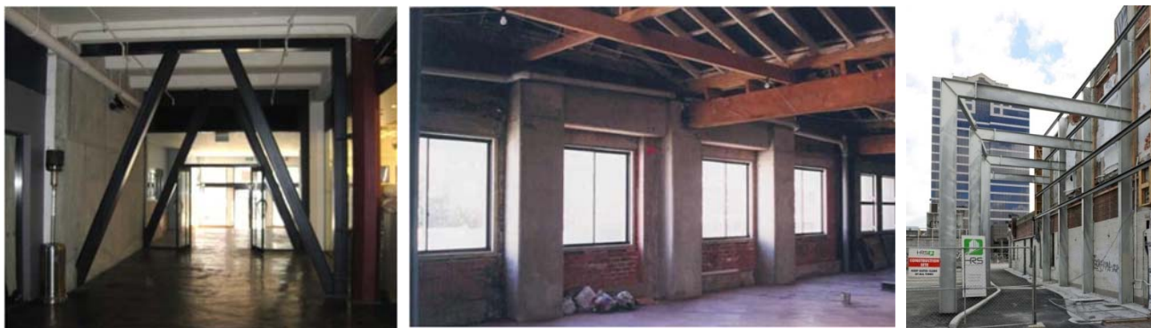
Slika 2.67 Pojačanje konstrukcije izvedbom čeličnih i AB okvira [4]
