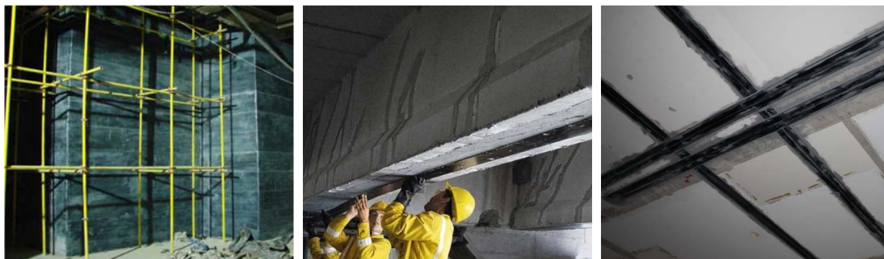
Slika 4.31 Mogućnosti pojačanja različitih elemenata konstrukcije
