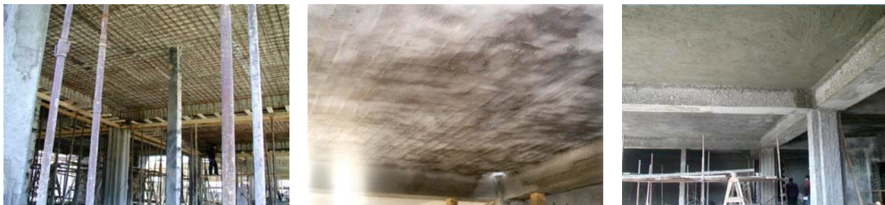
Slika 4.15 Postavljanje armature i torkreta s donje strane ploče
