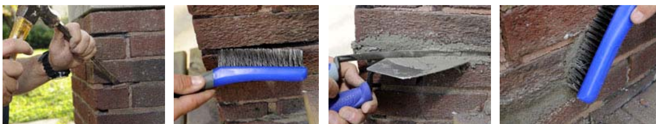
Slika 2.26 Postupak sanacije i izvedbe
