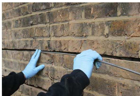
Slika 2.27 Postavljanje čeličnih šipki u popravljene sljubnice
