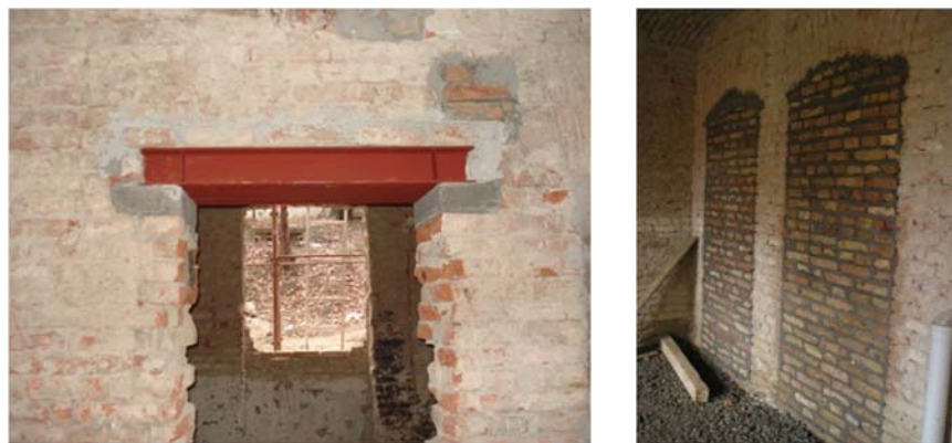
Slika 2.41 Zazidani otvor u zidu
