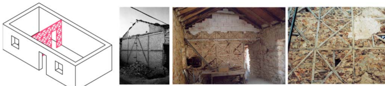
Slika 2.68 Primjer „Pombalino“ drveni okviri
