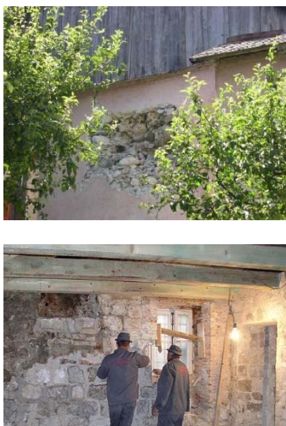
Slika 2.31 Prezidavanje oštećenja novim tipom зида
