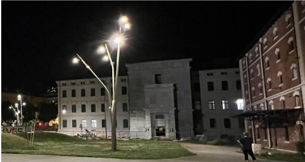
Slika 33. Nedovršena izgradnja Gradske knjižnice Rijeka 2023. povodom inicijative EPK-a 2020.
