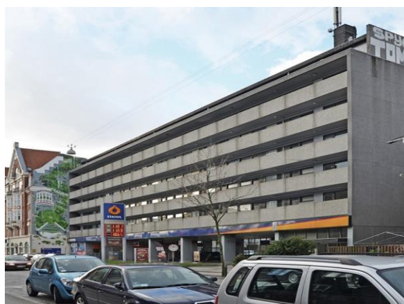
Slika 25. Pročelje prije obnove
