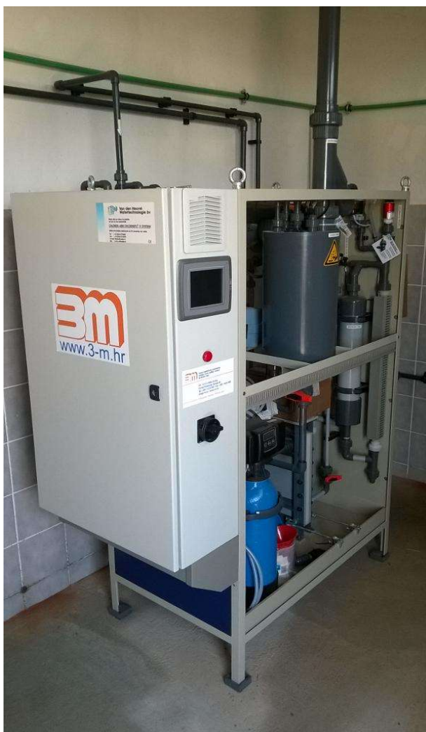
Sl. 2-2 Sustav za doziranje natrijeva hipoklorita [3M d.o.o.]
