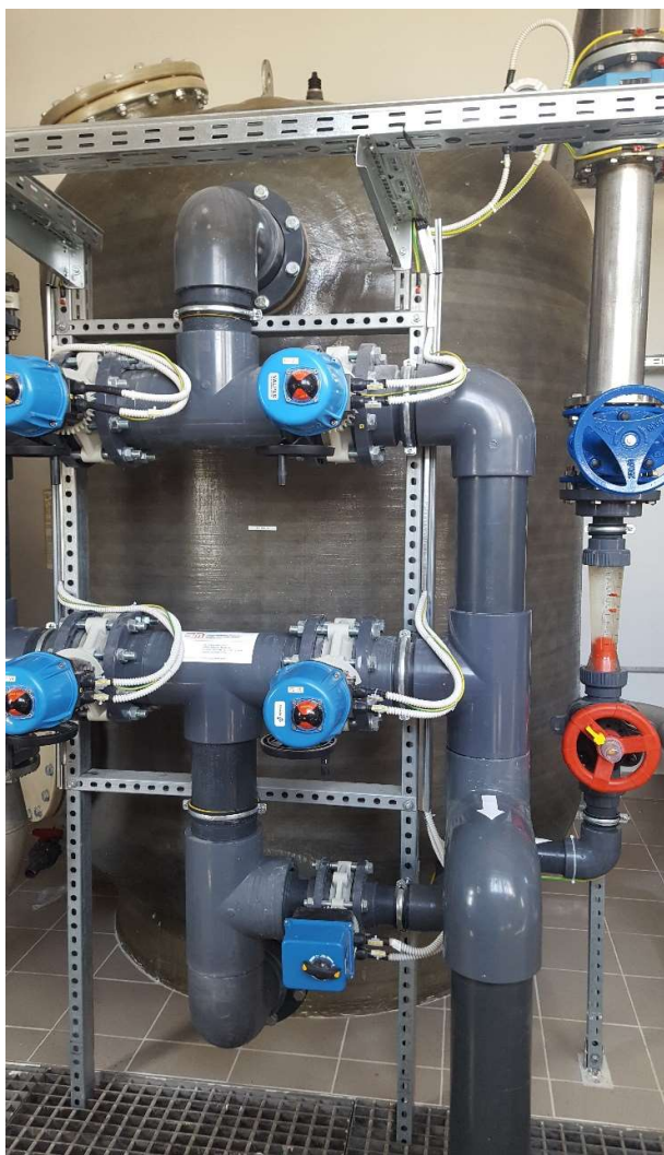
Sl. 2-1 Zatvoreni pješčani filtri promjera 2 m [3M d.o.o.]
