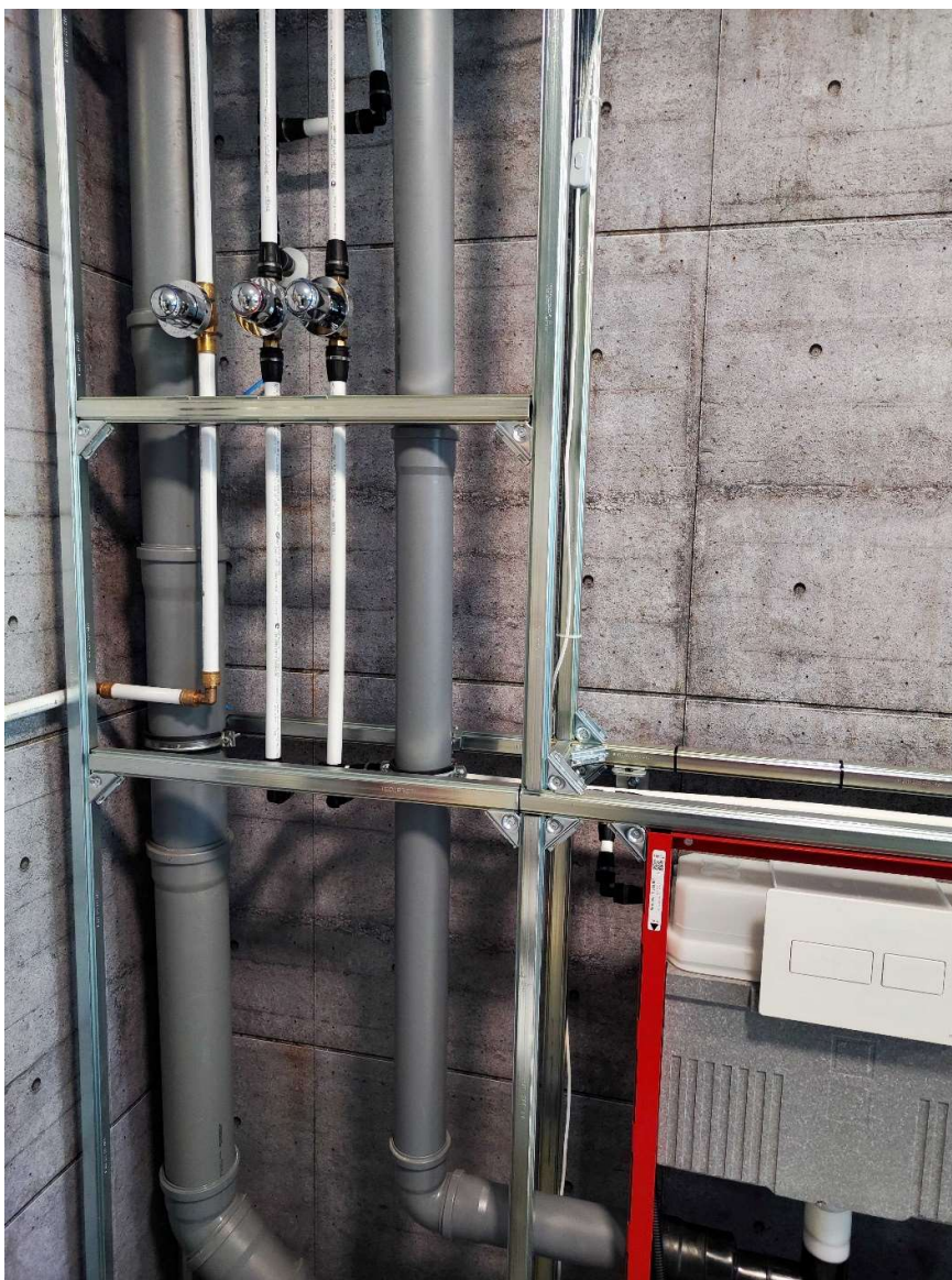
Sl. 5-7 Vođenja instalacije unutar instalacijskog šahta [TECE]
