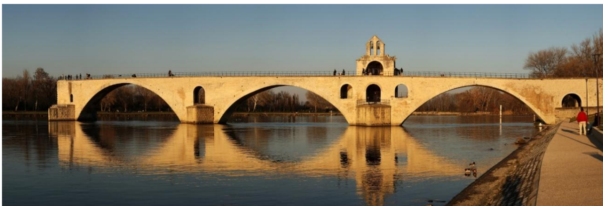
Slika 6.7. Lučni kameni most – most u Avignonu iz 12. st.
