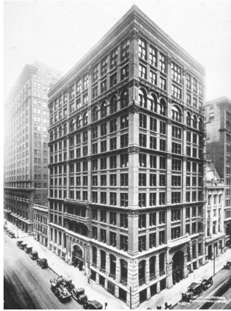
Slika 6.19. Home Insurance u Chicagu (1885. g.) – prva zgrada s okvirnom čeličnom konstrukcijom
