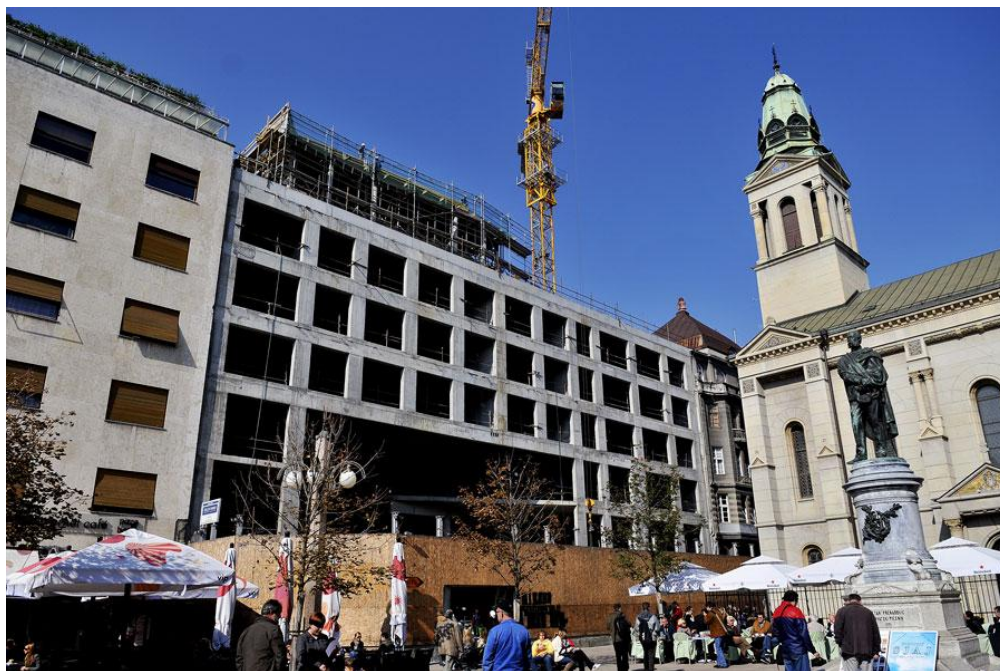
Slika 6.41. Zgrada na Cvjetnom trgu u Zagrebu - suvremena primjena Vierendeelova nosača
