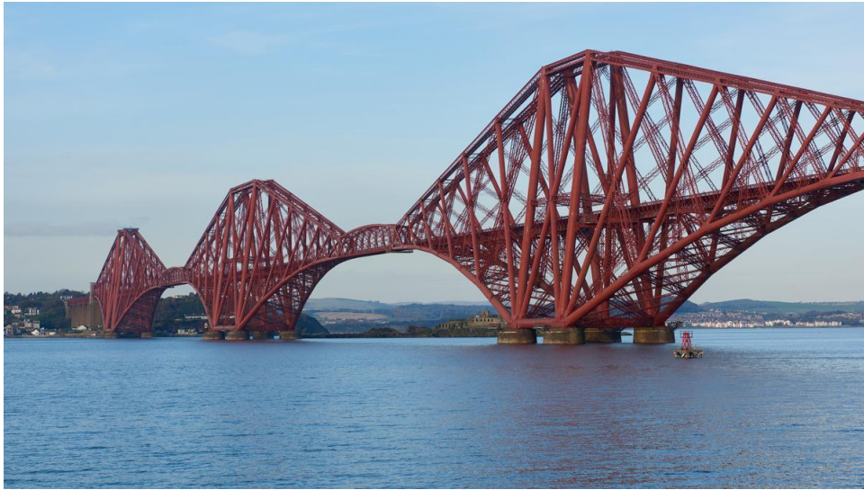
Slika 6.5. Most preko rijeke Forth – primjena Gerberove grede u velikom rasponu
