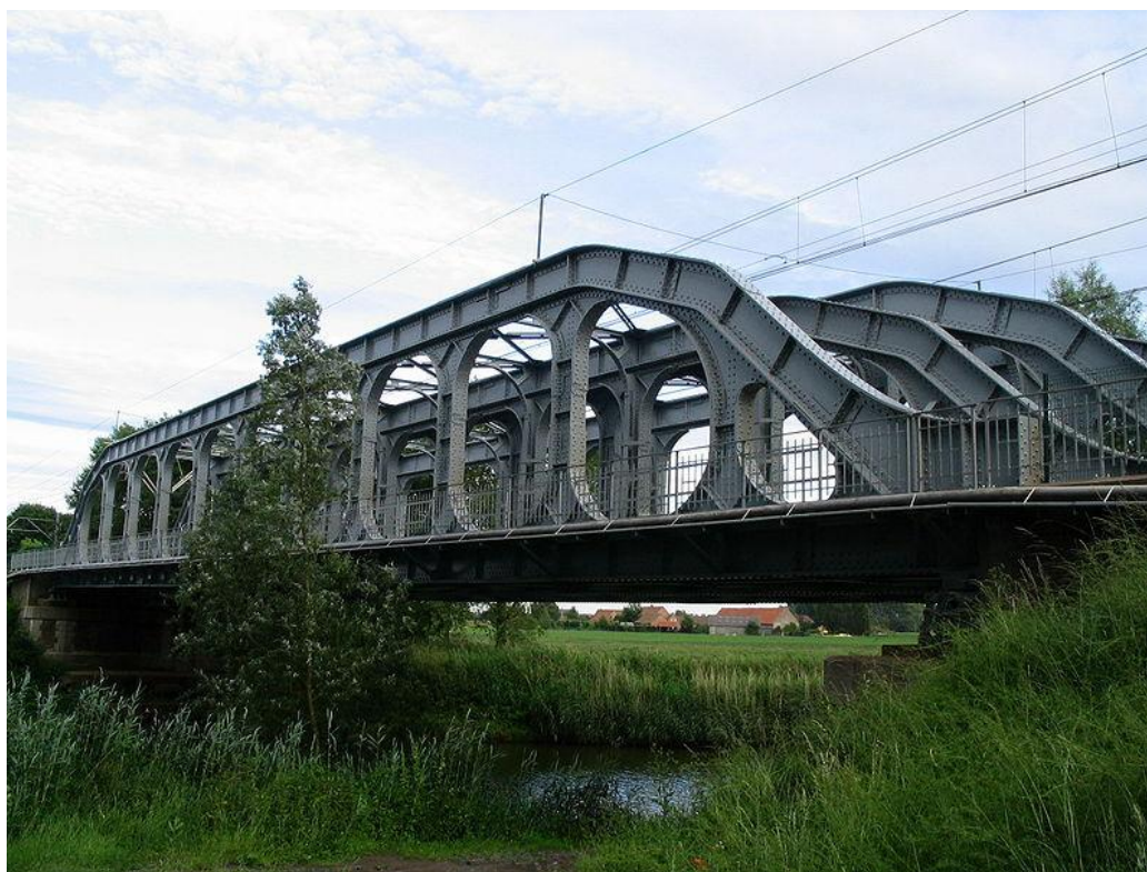
Slika 6.40. Vierendeelov most u Gremmene u Belgiji – vidljivi kruto oblikovani čvorovi
