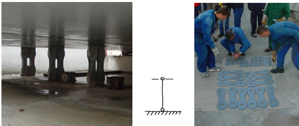
Slika 4.11. Most hrvatskih branitelja u Rijeci – izvedba štapnog (kliznog) ležaja
