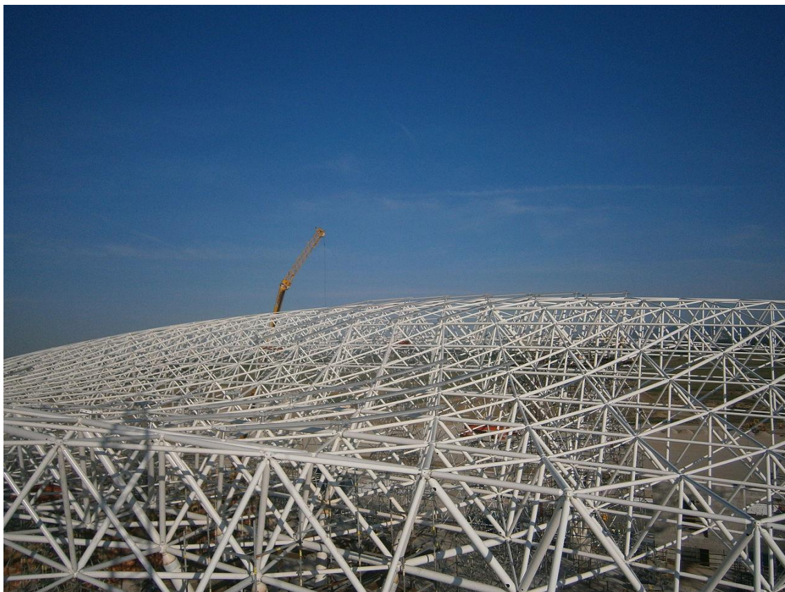
Slika 6.36. Zračna luka u Zagrebu – primjer prostorne MERO rešetke
