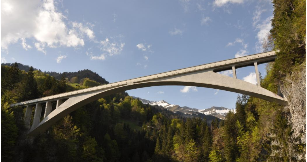
Slika 6.12 . Most Saldinatobel u Švicarskoj, Robert Maillart, 1930. g. – primjer trozglobnog luka Slijedi primjer proračuna trozglobnog luka, tj. proračun reakcija i dijagrama unutarnjih sila.
