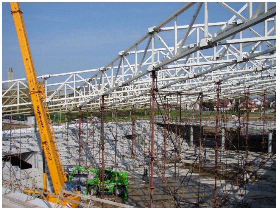
Slika 6.31. Roštiljna konstrukcija od rešetkastih nosača
