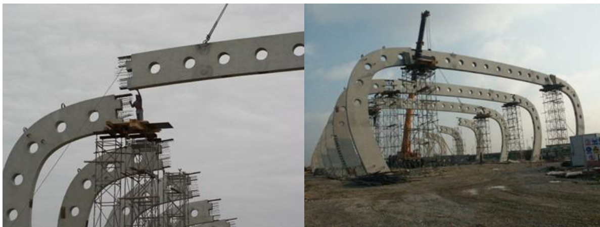
Slika 6.2. Fotografija okvirne konstrukcije s izvedbom krutog spoja
