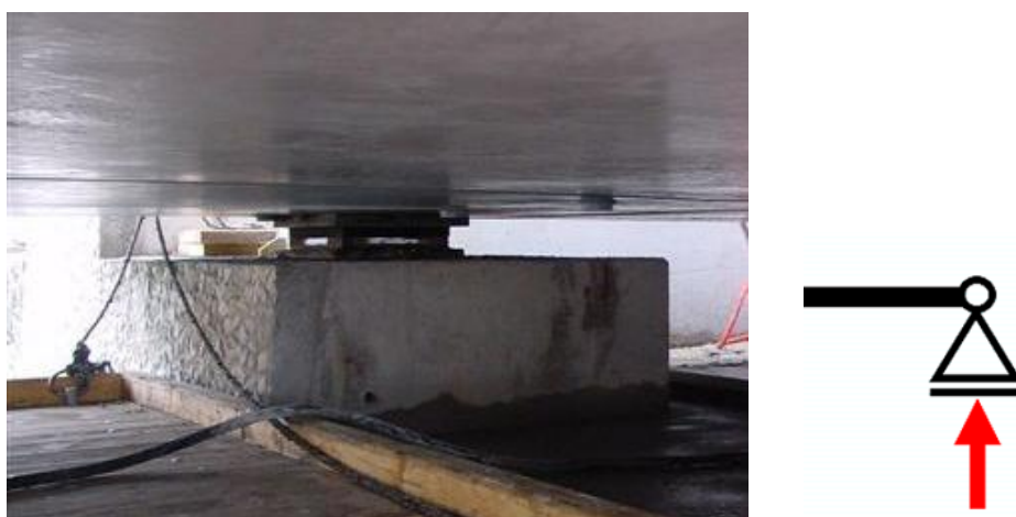
Slika 4.10. Most hrvatskih branitelja u Rijeci – izvedba elastomernog kliznog ležaja
