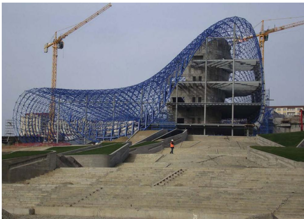
Slika 6.33. Prostorna zakrivljena rešetkasta konstrukcija
