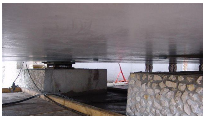
Slika 4.11. Most hrvatskih branitelja u Rijeci – izvedba upetog ležaja kombinacijom elastomernog nepomičnog i štapnog (kliznog) ležaja
